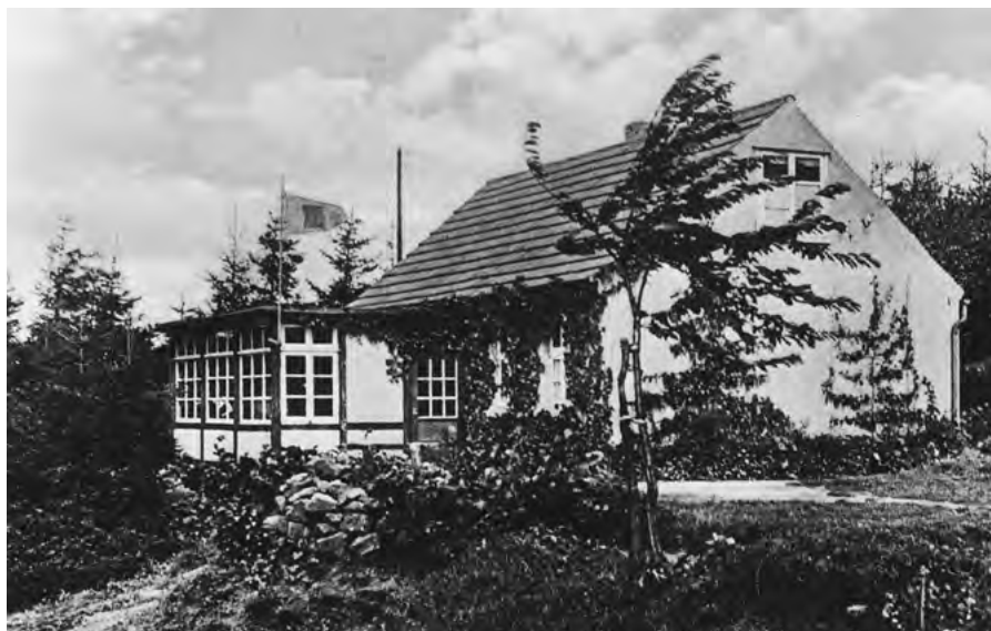
Das KKV-Heim am Boberg in Ohrbeck
