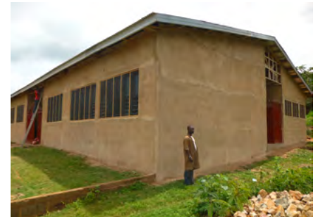
Der Rohbau des Kindergartens 2013 in Wusuta
